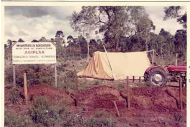
Início da construção do Centro de Treinamento em 1973
