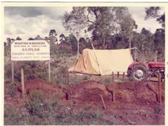
Início da construção do Centro de Treinamento em 1973.
